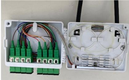
Feche a tampa encaixando as travas e prendendo com o parafuso na lateral da caixa.
