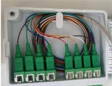
Passa o esplitter para o outro lado, usando um espiral tube para proteger as vias de saída, e acomode o splitter no berço, enrolando a via de alimentação no ponte reserva.
