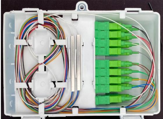
Em caso de emenda da fibras de alimentação dos splitters, cortar o conector e encaminhar as fibras para o compartimento das emendas
