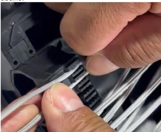
Acomode todos os drops, conforme fiquem alinhados com as saídas da caixa.
